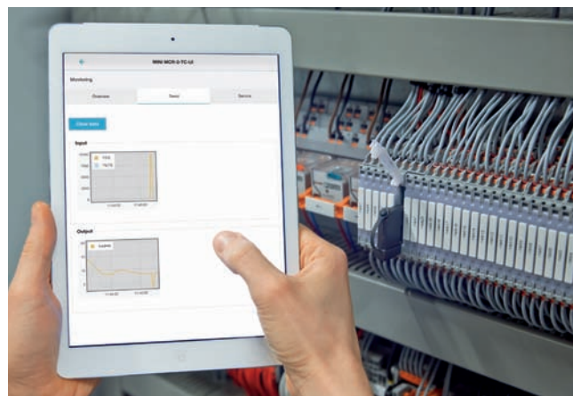
Obr. 2 Mini Analog Pro obsahuje spolu s aplikáciou aj všestranné možnosti na uvedenie oddelovacích zosilňovačov a komunikačného modulu do prevádzky.
