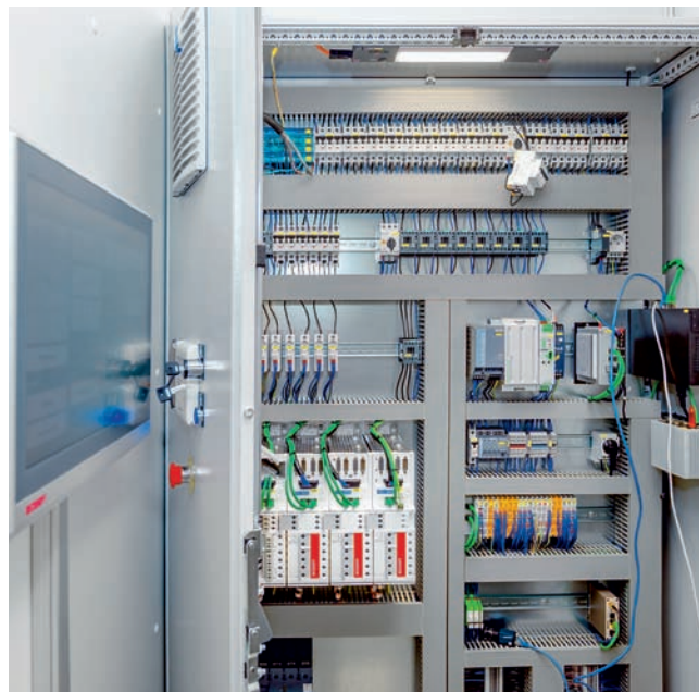
Pohľad do vnútra rozvádzača ukazuje ultra kompaktný priemyselný počítač Beckhoff C6030 a zabudované terminály EtherCAT (v strede vpravo), ako aj servopohony AX5000 (stred) a 12-palcový ovládací panel CP2912 (vľavo).
